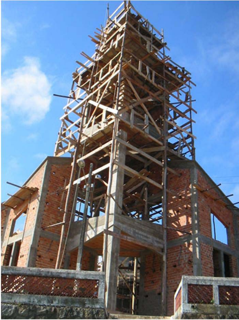
Construção da nova capela de Teresópolis 2006/2007. Fonte: eduardofaust.com
