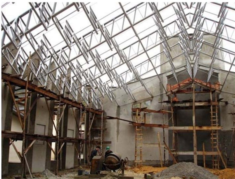
Construção da nova capela de Teresópolis 2006/2007.
