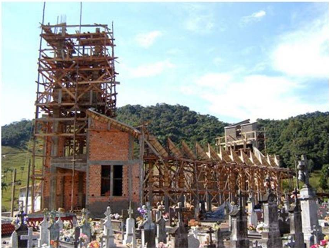
Construção da nova capela de Teresópolis 2006/2007.
