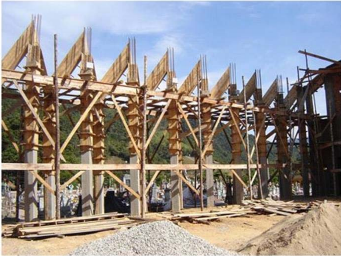
Construção da nova capela de Teresópolis 2006/2007.
