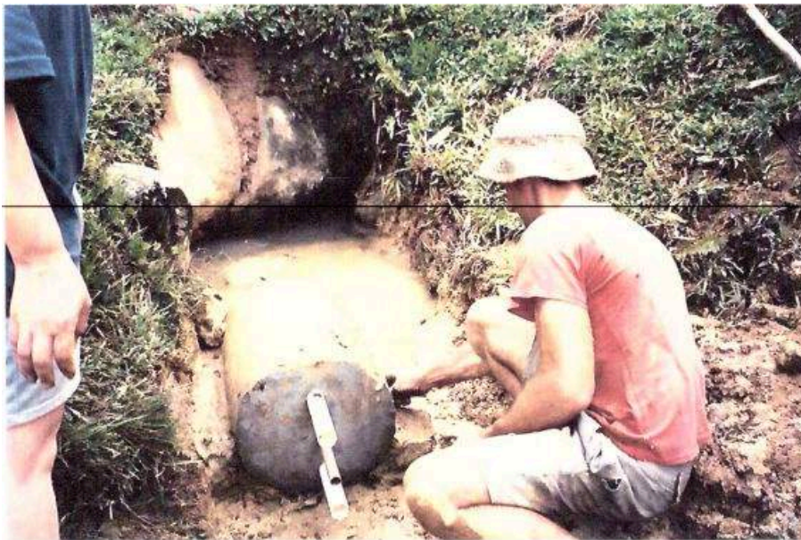
Figura 43: Sistema tipo Caxambu em instalação
