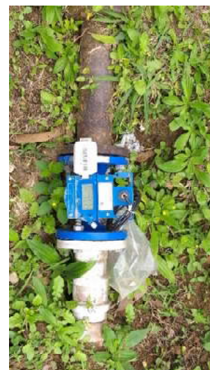
Figura 39: Macromedidor (CASAN, 2019)
