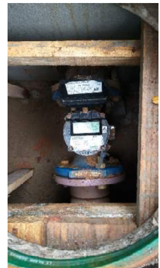
Figura 24: Macromedidor (CASAN, 2019)
